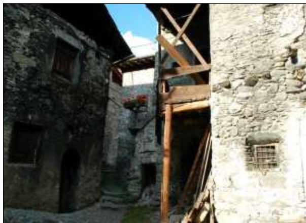
Foto 6 – Grosio, scorcio di case su via Adda
