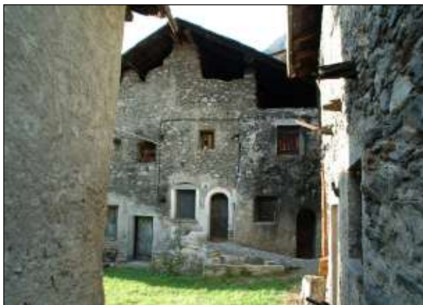
Foto 5 – Corte nella parte sud del centro storico
