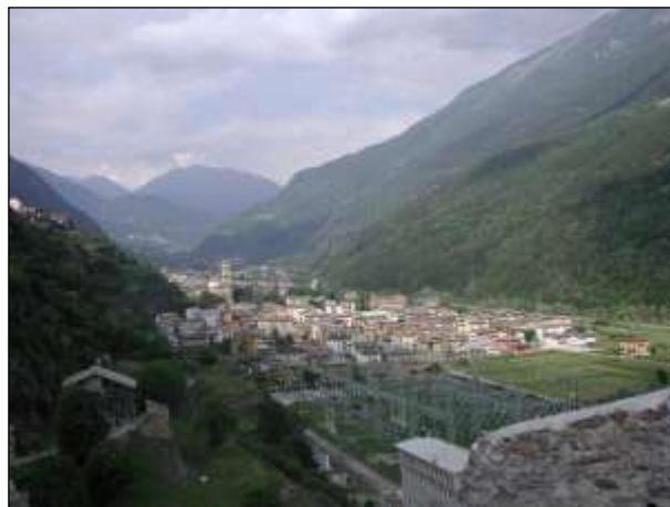
Foto 63 - La nuova centrale AEM
