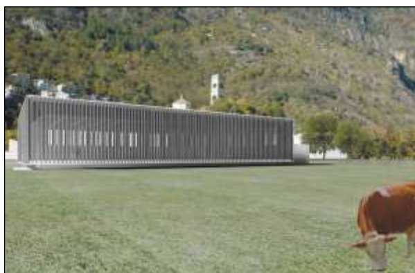
Figura 56: vista dal terrain vague
