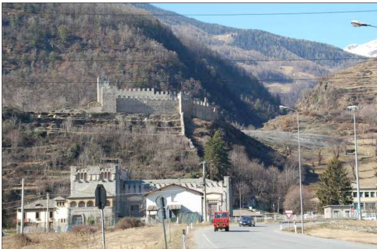
Figura 40 -Uscita dalla tangenziale per Grosio: il castello Visconti Venosta e, in parte nascosta, la vecchia centrale AEM.
