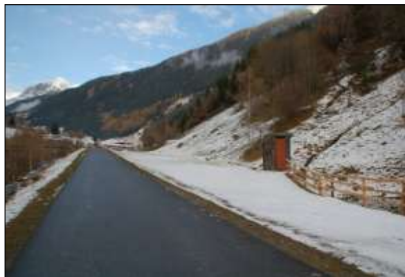
Figura 66 ambito proposto come parcheggio camper C3 qualora si risolvano le problematiche di tipo idrogeologico
